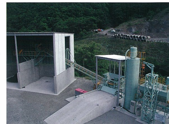
[砕石工場稼働中のケークルII 30型]
