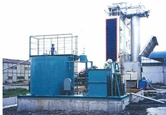
中和・汚水処理を一体構造にしコンパクト化 『中和・濁水処理装置』
